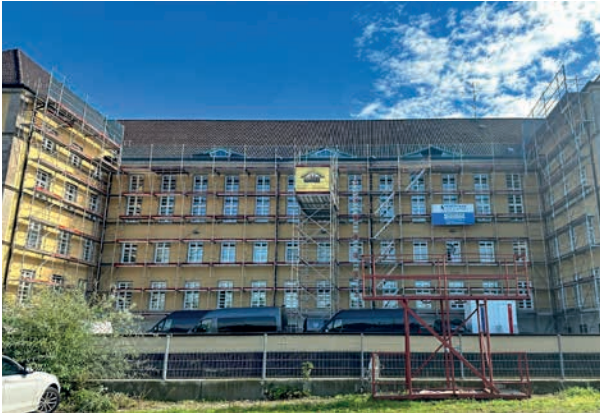
Fassadengerüst mit Dachfanglage
