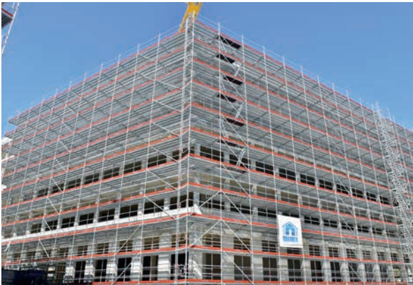
Fassadengerüst mit 1,09 m Feldbreite und mit vorgestelltem Podesttreppenturm
