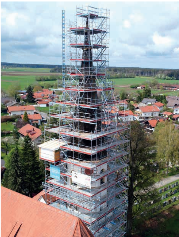
Kirchturmeinrüstung mit flexibler Geometrieanpassung und integrierter Podesttreppe
