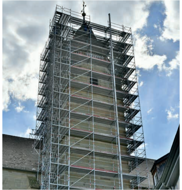
Kirchturmeinrüstung mit verschiedenen Feldbreiten (0,73 und 1,09 m)
